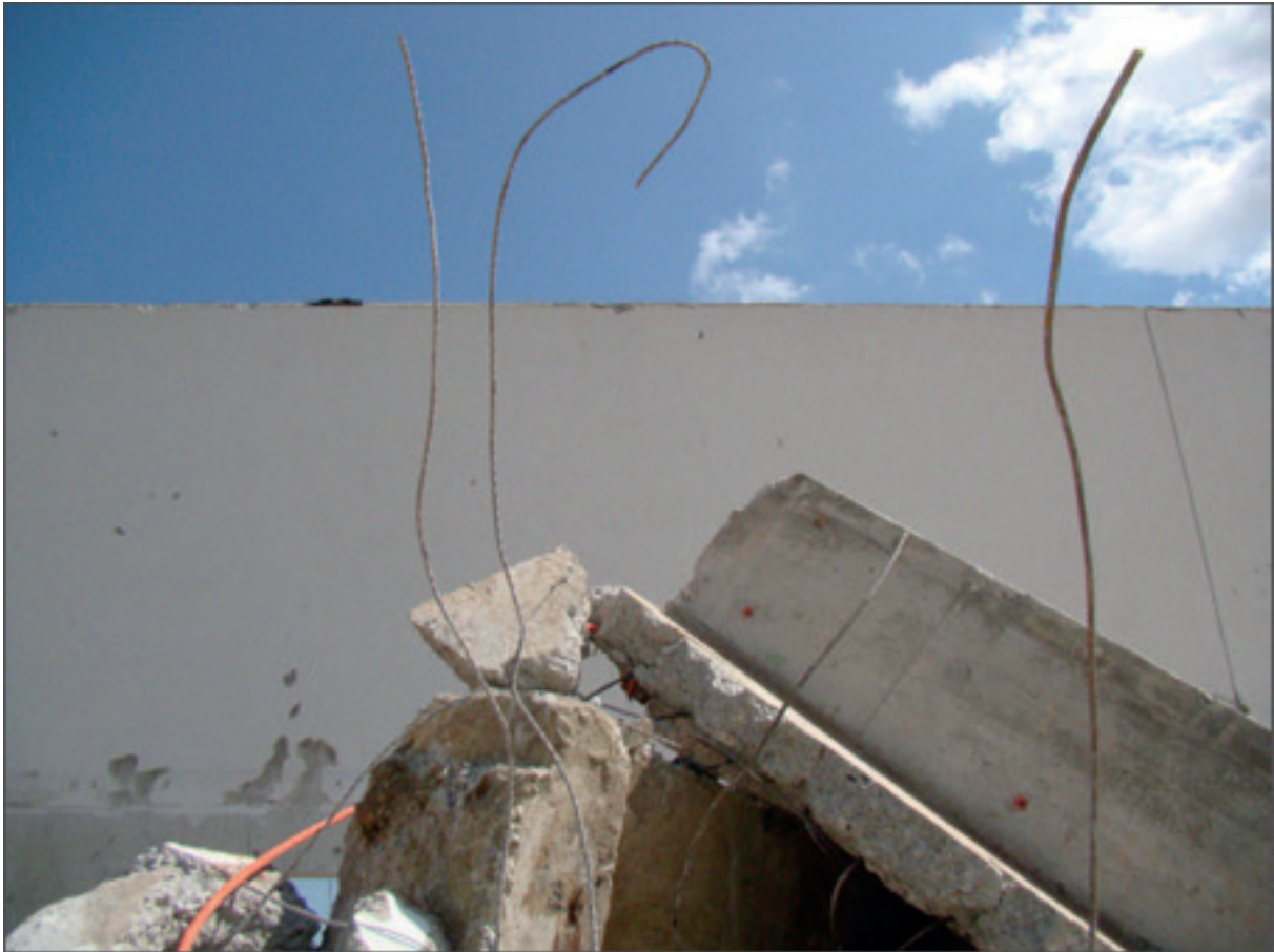
Abbruch der 40 Jahre alten Turnhalle
